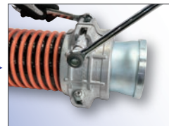
④ ボルト3か所を均等に許容締め付けトルクまで締めます。
