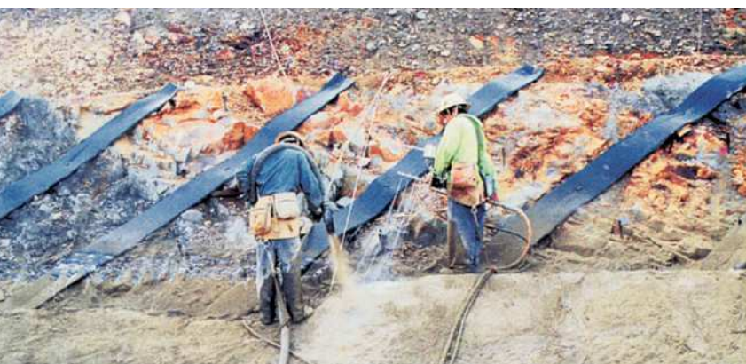
TACメンドレンしなやかを設置し連続繊維補強土(ジオファイバー)を施工中
