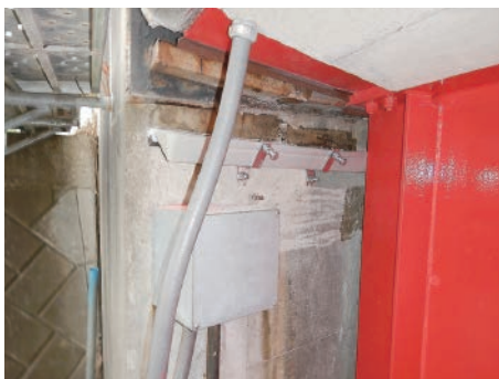
胸壁にアンカー打設し、製品を取り付けます
